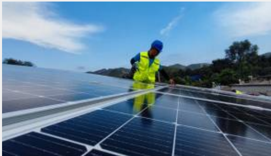
华夏金租户用光伏电站施工现场
