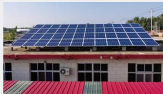
华夏金租户用光伏电站
