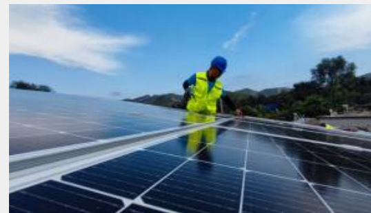
华夏金租户用光伏电站施工现场
