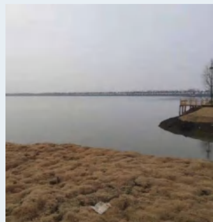
兴化市蜈蚣湖及南荡退圩还湖二期工程
